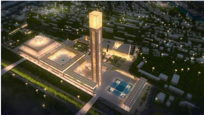
La mosquée Djamaâ el Djazaïr, également connue sous le nom de mosquée Mohammadia, sera alimentée par un système de trigénération basé sur quatre moteurs à gaz GE Jenbacher fournis par Clarke Energy.
