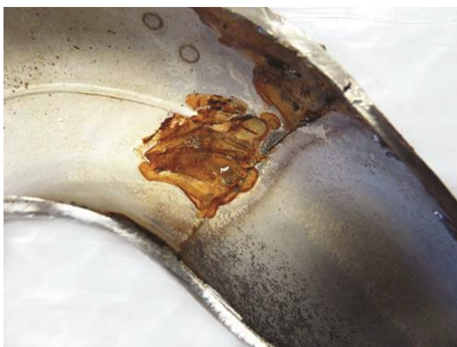
1. Corrosion localisée. Cette image montre une corrosion fissurante adjacente à une soudure de tuyau en acier inoxydable. Gracieuseté de Huntingdon Fusion Techniques HFT
