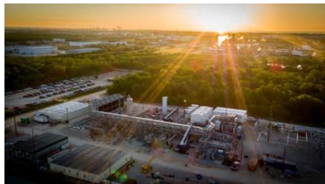
La centrale de démonstration de 50 MWth de NET Power à La Porte, au Texas (PRNewsfoto / NET Power, LLC)
